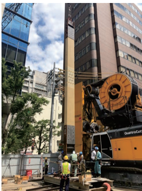
写真-13 FFU部材の建込状況
