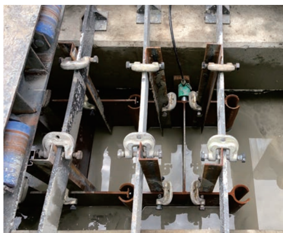
写真-12 鋼製連壁部材の建込み状況
