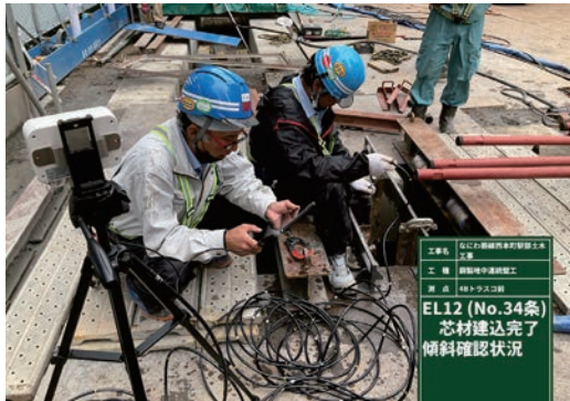
写真-9 建込み精度確認状況
