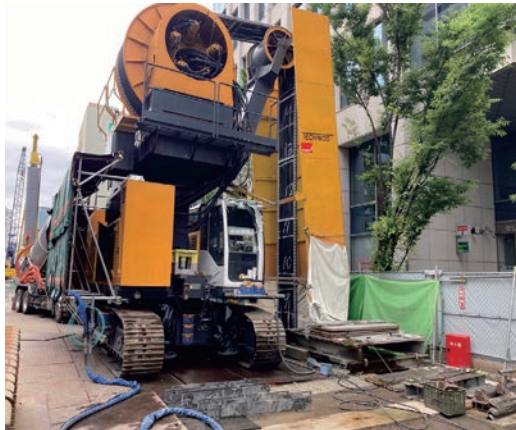
写真-3 施工機械 (クアトロカッター)
