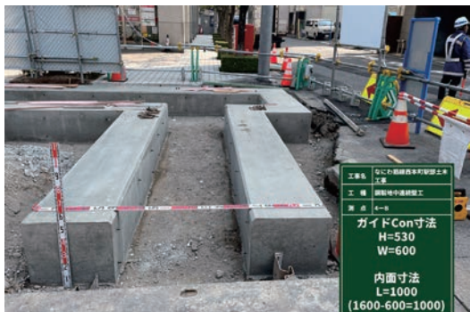
写真-5 ガイドウォールの施工状況
