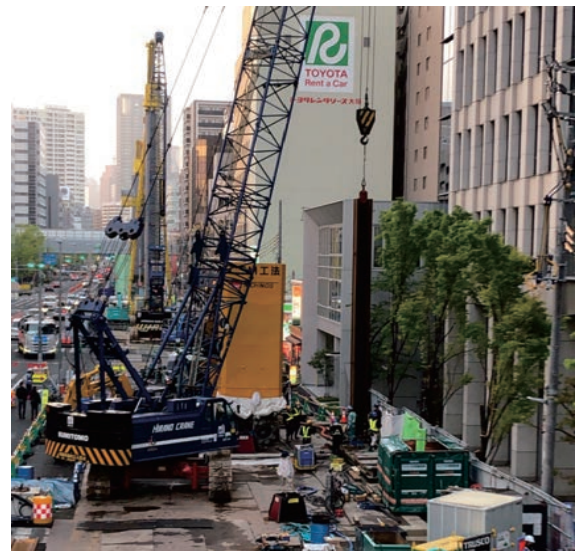
写真-4 CSM 工法の施工状況
