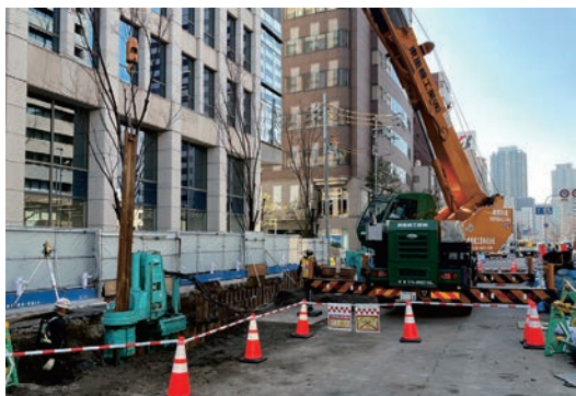
写真-7 軽量鋼矢板の施工状況
