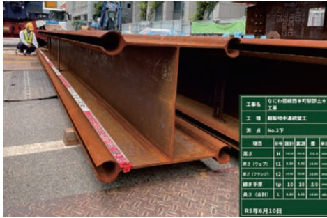
写真-1 鋼製連続壁部材 (NS-BOX)
