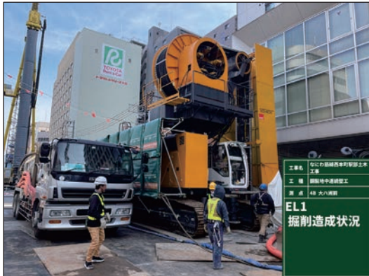
写真-8 店舗入り口での施工状況
