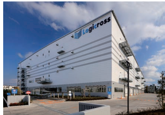
写真-1 北西面外観
