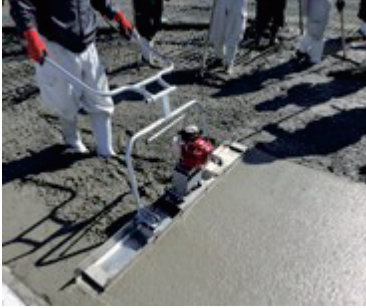
写真-4 タンピング・均し作業
