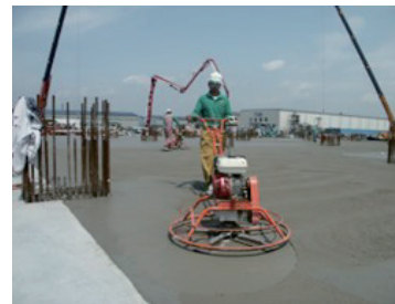
写真-9 トロウエル（羽根）押え
