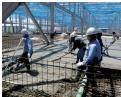
写真-3 トンボ均し作業
