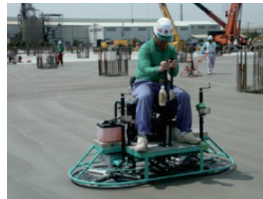
写真-8 騎乗式トロウエル（円盤）押え
