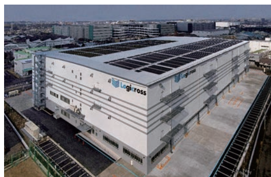
写真-13 南東面外観
