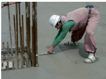
写真-6 チリ廻り端部金鋸押え
