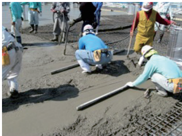
写真-5 コンクリート天端付け作業
