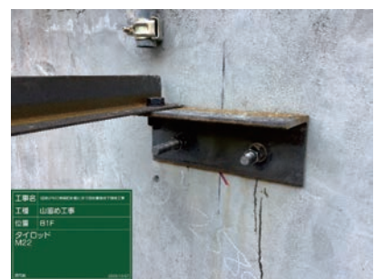
タイロッド固定状況
