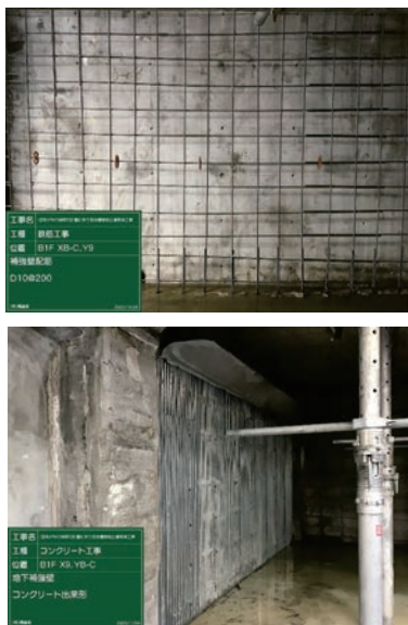
写真-3 増し打ち状況 (上：壁配筋状況、下：コンクリート打設完了)
