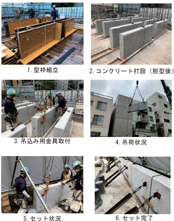
写真-4 サイトPCa製作から設置までの流れ
