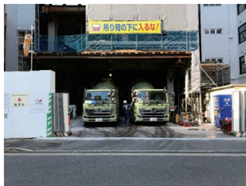
写真-5 ミキサー車の配置状況
