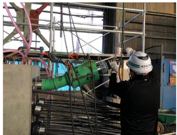
写真-8 緊張ジャッキ取付状況
