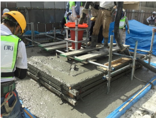
写真-5 3 回目実大試験状況
