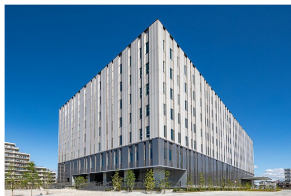
写真-1 完成建物外観
