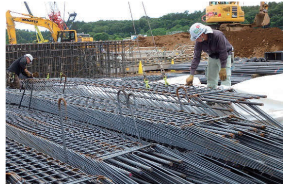
写真-6 ジャバラユニット工法施工状況
