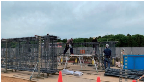
写真-5 地組状況
