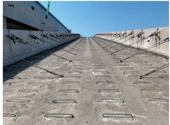
写真-15 スラブ1層目打設後
