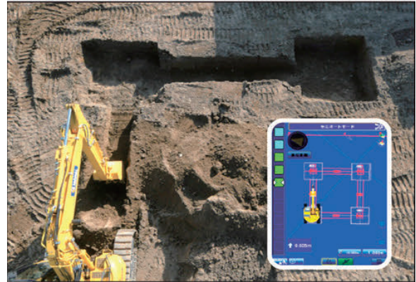
写真-3 ICT建機の掘削状況
