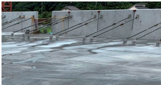
写真-14 PCa 壁のセット状況
