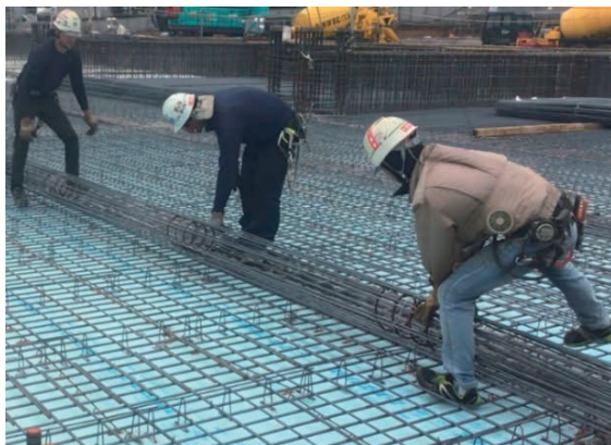
写真-9 ロールマット配筋状況
