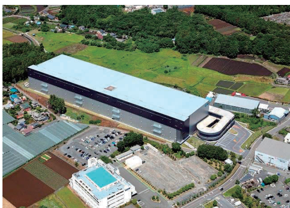
写真－2 南東側俯瞰
