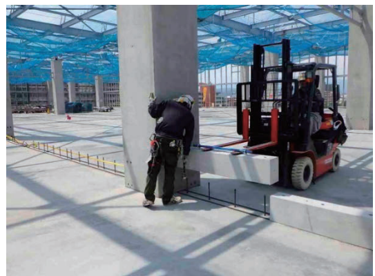
写真-16 腰壁躯体（立上り）PCa の施工状況
