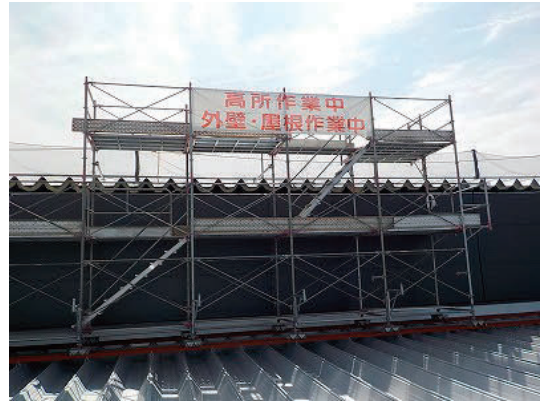
写真-18 レール式移動足場
