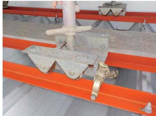
写真-19 レール式移動足場レール拡大
