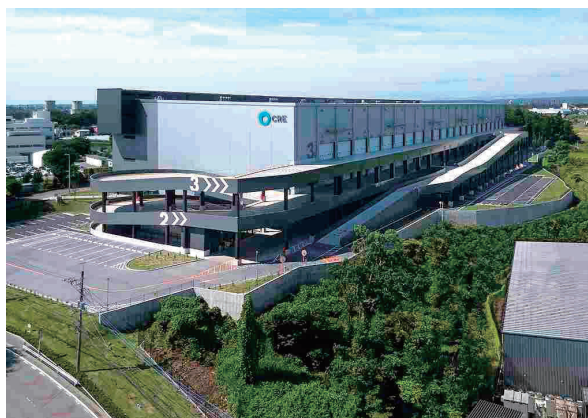
写真－1 北東面外観
