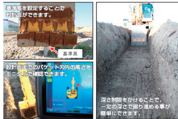
写真-4 ICT建機の掘削状況
