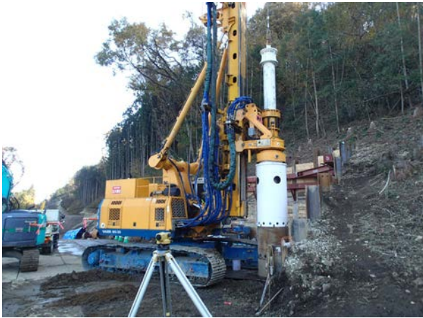
写真-2 BG-20 を用いた場所打ち杭の施工状況
