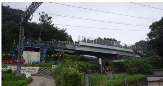
写真-9 桁送り出し状況
