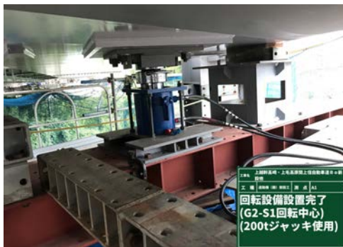
写真-5 回転装置 (200t ジャッキ)
