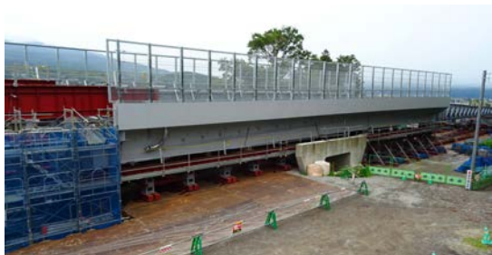
写真-8 積荷転落防止柵の先行設置状況
