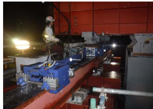
写真-6 横取り用スライディングシップジャッキ
