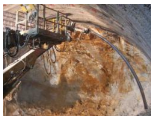
写真-5 支保工建込状況 (支保工エレクタ搭載型吹付け機)
