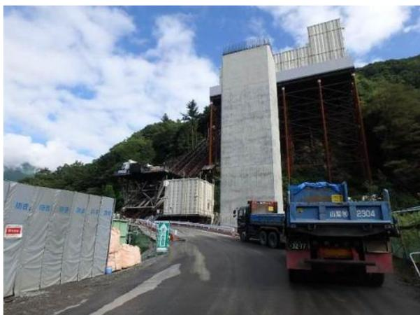
写真-9 掘削ずり搬出状況
