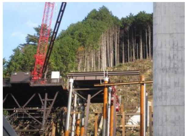
写真-8 坑口前作業構台架設状況
