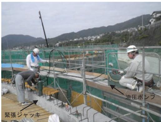
写真-8 鉛直方向緊張状況
