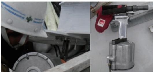
写真-12 専用締付機による締付状況
