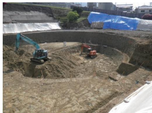
写真-3 PCタンク部掘削状況
