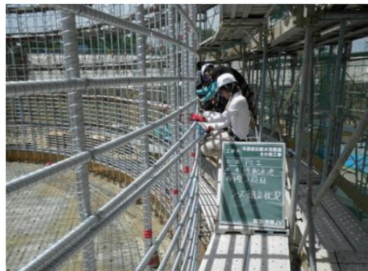
写真-7 横締めシース設置状況
