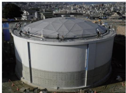
写真-15 ドーム吊上げ状況
