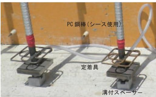
写真-5 PC 鋼棒建込状況
