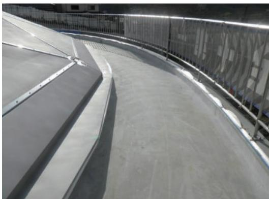
写真-17 水切りパネル設置完了
