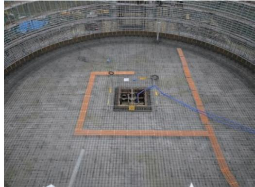
写真-6 タンク底版鉄筋型枠組立全景
