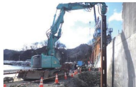
写真-7 既設擁壁基礎杭撤去状況
