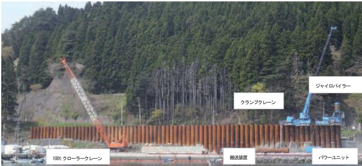
写真-2 鋼管杭工施工状況（ノンステーキング工法）
