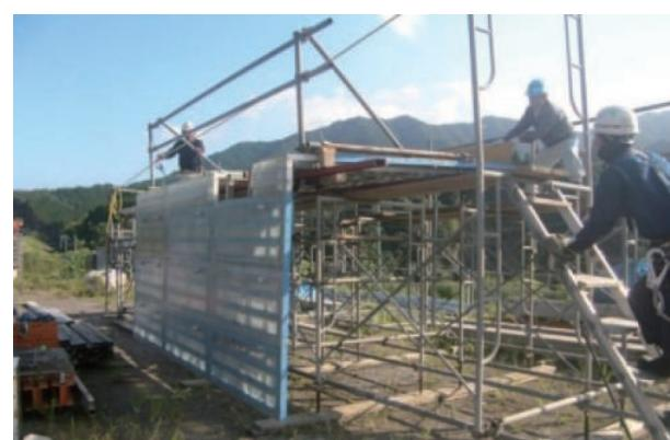
写真-3 型枠スライド方式の試験施工
