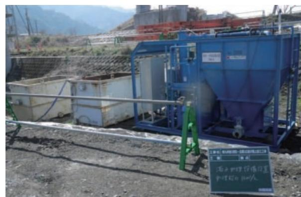
写真-5 濁水処理設備
