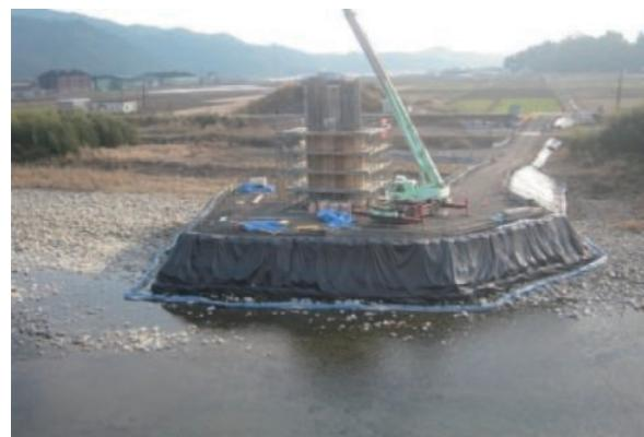
写真-4 築島部遮水シート被覆状況
