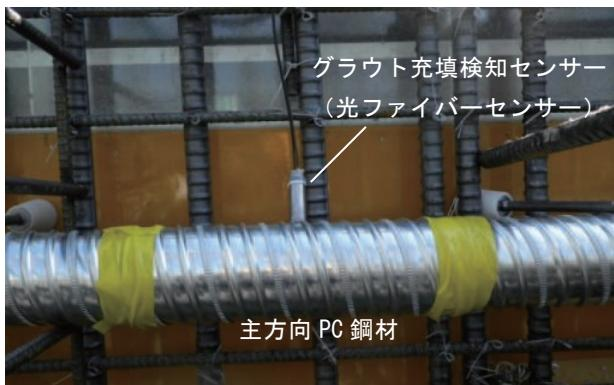
写真-13 光ファイバーセンサー設置状況
