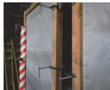
写真-2 開口抵抗体の設置
