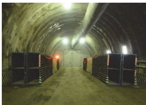
写真-6 サイレンスチューブ設置(通気抵抗体なし)
