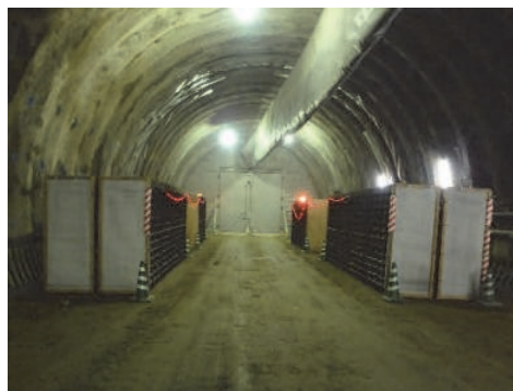
写真-7 サイレンスチューブ設置(通気抵抗体あり)
