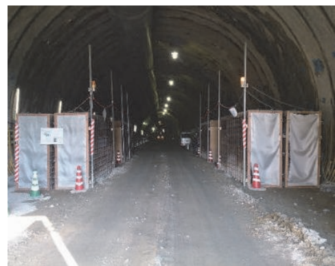
写真-9 施工継続後のサイレンスチューブの状態
