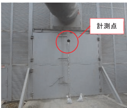
写真-3 防音扉外側での計測
