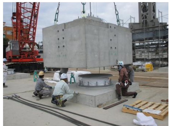
写真-4 免震ブロック設置状況
