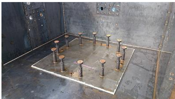
写真-3 鋼製型枠 免震BPLセット
