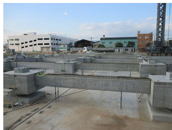
写真-1 免震層 PCaPC 基礎・基礎梁施工状況
