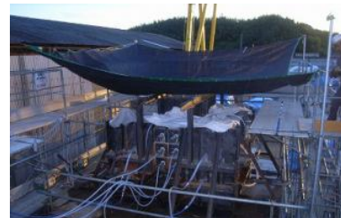
写真-1 パイプクーリング
