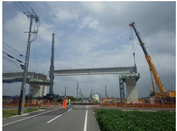
写真-2 架設状況
