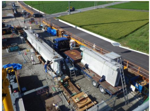
写真-1 セグメントの接合状況
