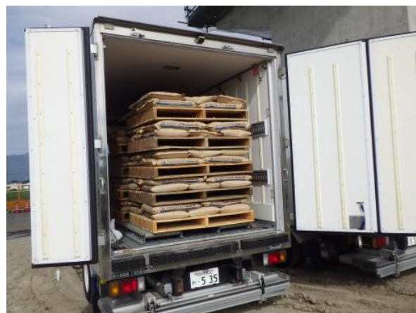
写真-6 保冷車によるグラウト材料の冷却
