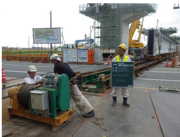
写真-5 軌条の延長による交差道路内への桁小運搬
