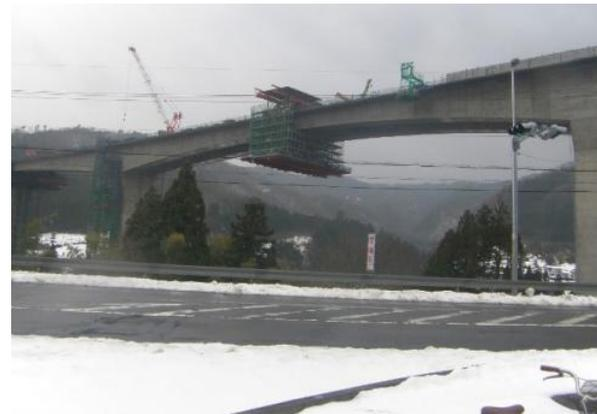
写真-13 中央閉合施工状況
