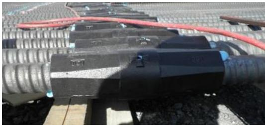
写真-3 主筋 D51 機械継手
