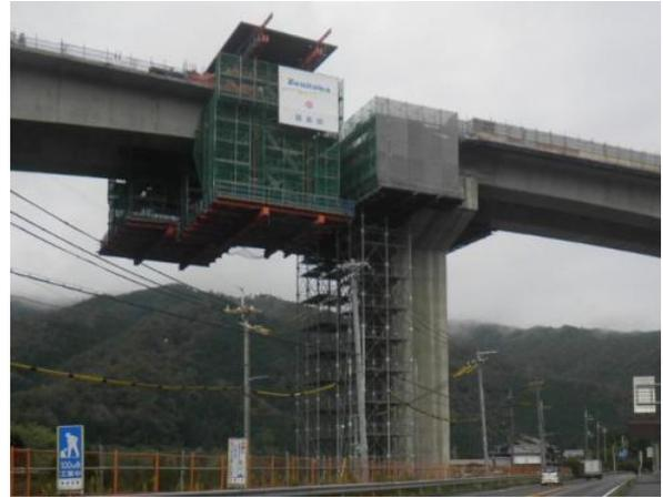
写真-12 側径間先行施工状況
