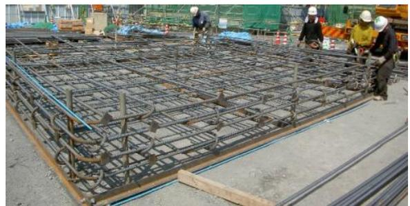
写真-4 橋脚鉄筋陸組状況
