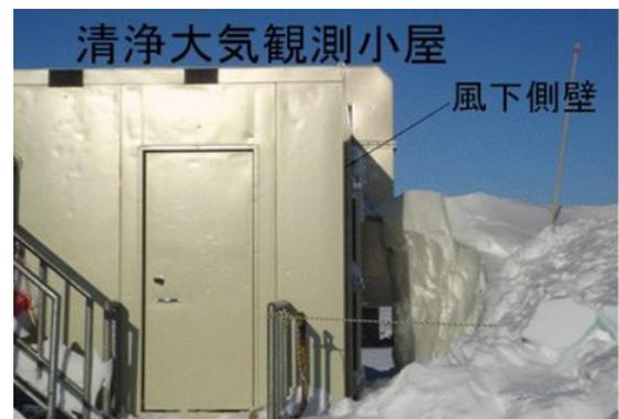
写真-1 ブリザード終了時の換気フードの状況
