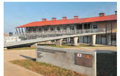
マサカ県中核医療施設 建築面積 2,251m 2 延床面積 4,265m 2
