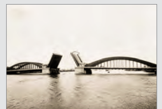
勝鬨橋 東京 1937 (昭和12) 年
