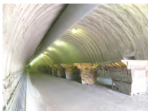
トンネル坑内に搬出土を仮置き
