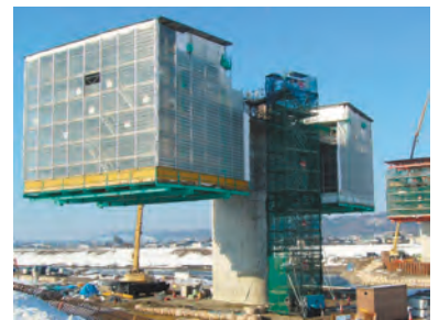
採光パネルの設置
