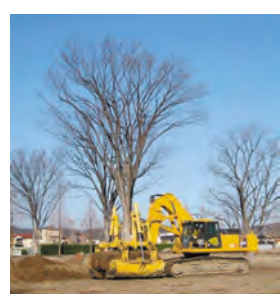
大型重機による既存樹木の移植 移植した樹木
