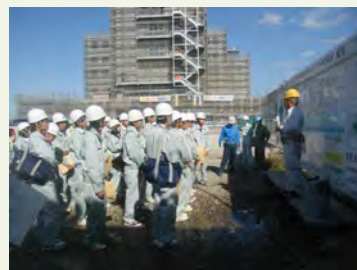
工業高校生を対象とした見学会（新潟・下越病院移転新築工事）
