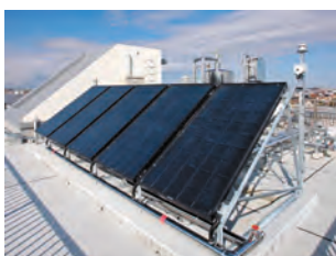
太陽熱利用ガス温水システム SOLAMO (シェアルーフ)
