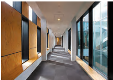
耐震フレーム LVL表し仕上げの屋内
