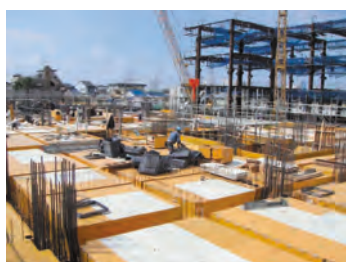
FRP型枠の使用
