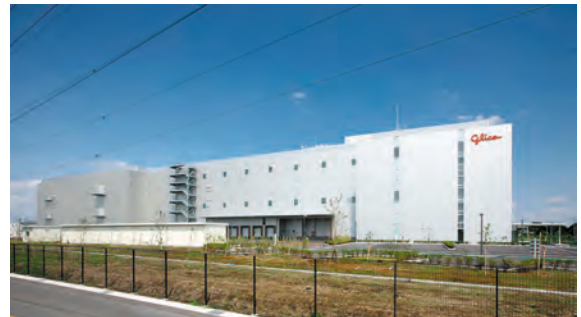
開口の少ない外壁面
