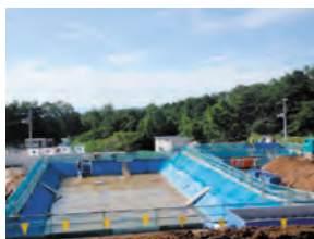
沈殿池と沈砂池を設置
