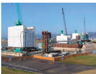
防音シートの設置
