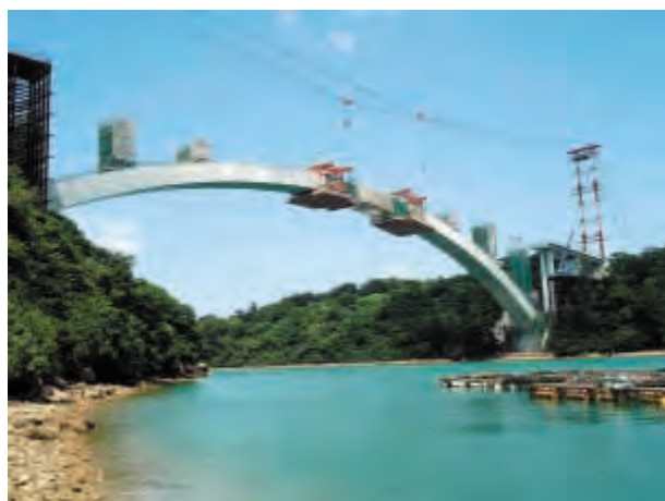
合成鋼管アーチ巻き立て工法
