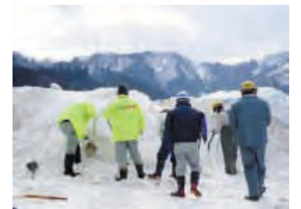
雪像作成中 （永平寺大野道路杉保トンネル工事）
