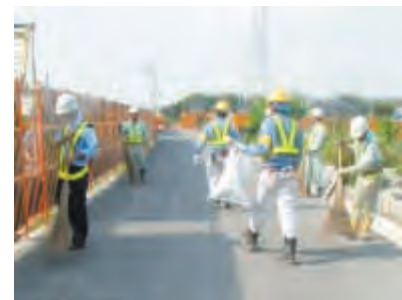
作業所付近の清掃 （常滑線・河和線太田川駅付近連続立体交差工事）
