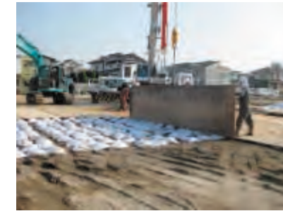
敷鉄板の下に土嚢敷設 （岩沼市新図書館新築工事）
