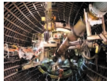
シールド坑内急曲線部
