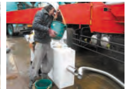
黒煙浄化装置（白い煙は水蒸気） （江東区認定こども園及び児童・高齢者総合施設工事）
