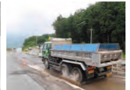
トラックのタイヤ洗浄 （舞鶴若狭自動車道野坂岳トンネル工事）
