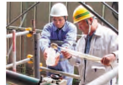
除去後の地下水モニタリング
