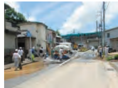
復旧状況 （田辺西BP芳養・元町改良工事）
