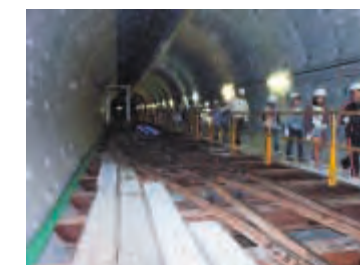
トンネル坑内見学
