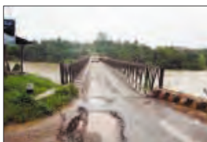
片側通行の旧橋
