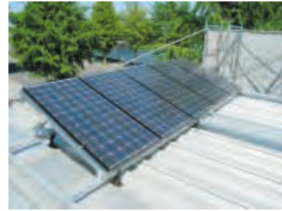
太陽光パネル （海岸通団地建替え工事）
