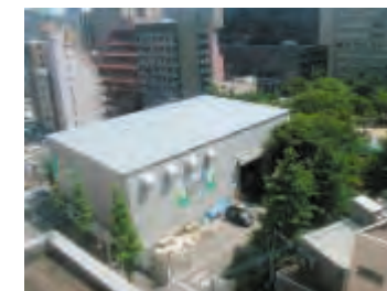
発進立坑（防音ハウス）
