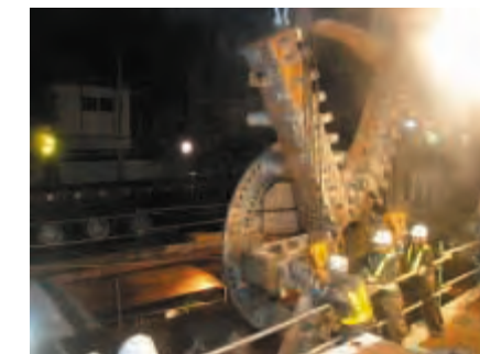
シールド機を引上げ 引上げたシールド機は、最初の立坑に戻って組み立て直し、反対方向へ向けて再発進しました。
