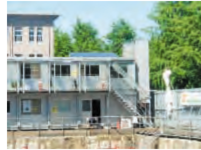
設置状況 （海岸通団地建替え工事）
