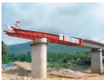
押し出し架設
