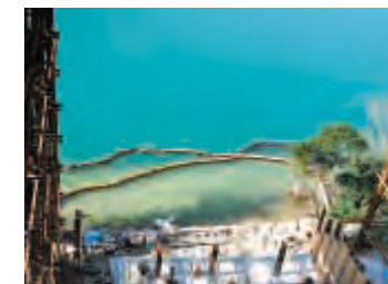
水質汚濁防止ネット
