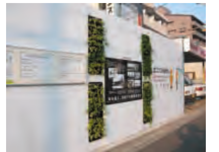
仮囲い（名城大学塩釜東研究棟新築工事）
