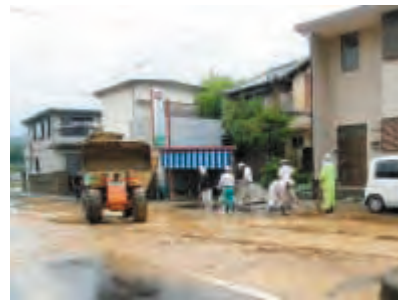
土砂流入状況 （田辺西BP芳養・元町改良工事）
