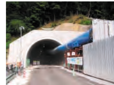
低騒音な換気設備 （舞鶴若狭自動車道野坂岳トンネル工事）
