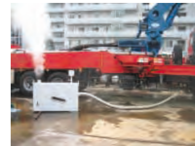
黒煙浄化装置（白い煙は水蒸気） （江東区認定こども園及び児童・高齢者総合施設工事）
