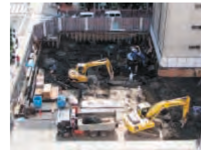
重金属汚染土壌の掘削除去
