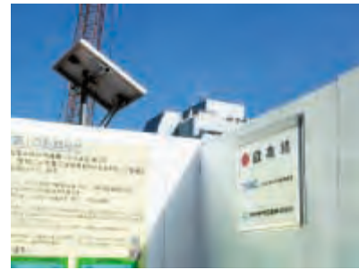
LEDによる作業所看板（右） （環状二号地下トンネル築造工事）
