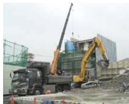
カッター工法による解体作業全景
