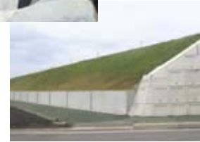
法面緑化状況
