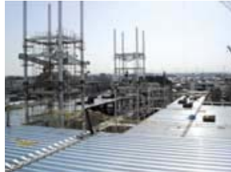
合成デッキスラブの採用
