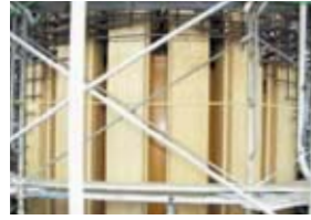
FFU材設置状況
