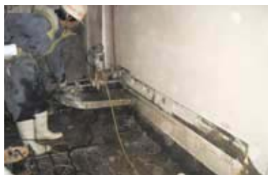
壁切断(コンクリートカッター)
