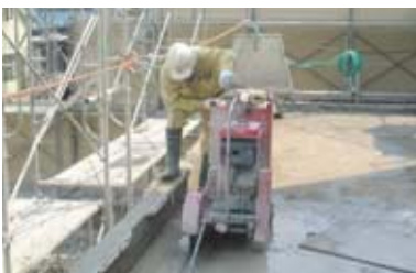
床切断(コンクリートカッター)
