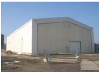
分別用テントの設置状況
