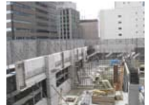
柱梁一体型PCa取付け状況
