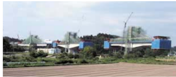
橋梁上部工の施工状況
