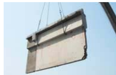
解体ブロック吊り上げ
