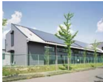
太陽パネルを設置した屋根外観
