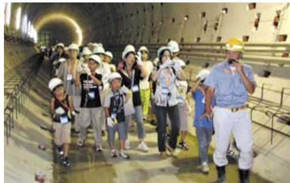
地下鉄線路部の坑内見学
