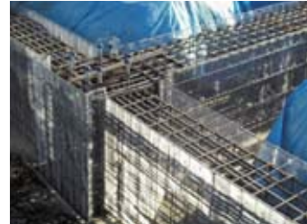
取り外しの必要のないラス型枠の採用
