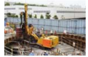
永久アンカー打設状況
