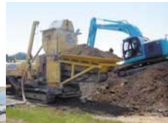
自走式機械による土質改良作業
