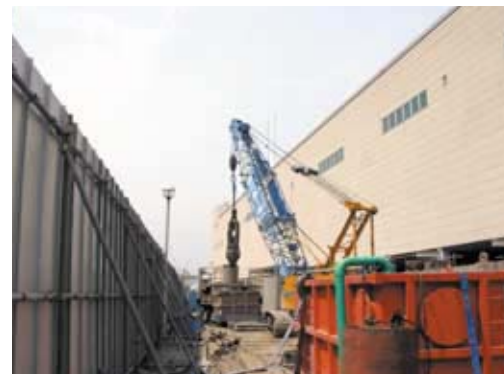
円形オールケーシング工法による施工状況(大阪支社)
