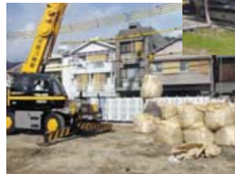
トンパック集積による残土仮置き
