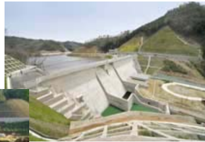
ダム周辺緑化状況
