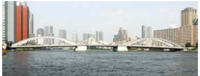
現在の勝鬨橋
