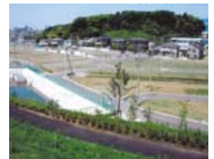
工事区域全景
