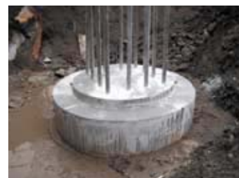
HRパイル杭頭部
