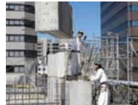
壁付柱PCa取付け状況
