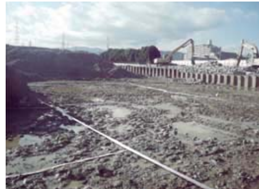
大規模な汚染土壌の掘削除去の現場(大阪支社)
