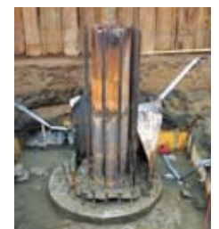
杭キャップの取外し状況
