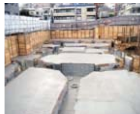
捨てコン打設後の状況
