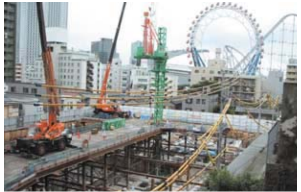
基礎工事中の作業所全景
