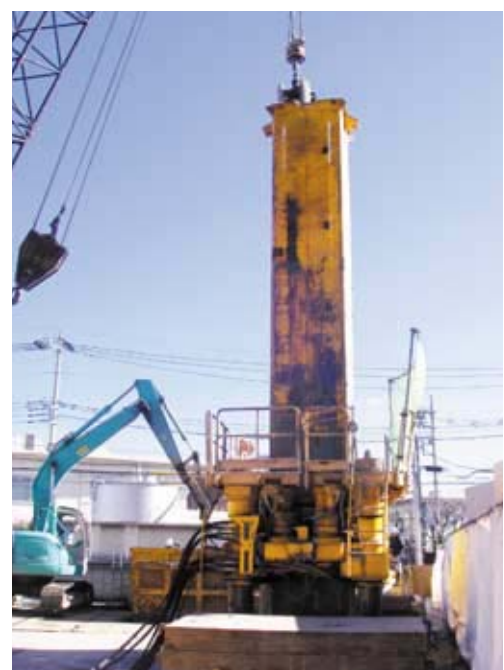
SPRED工法による施工状況(東京支社)
